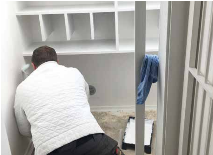
Her er Leif ved at lægge sidste hånd på et af rummene med en gang hvid maling glans 20, så det bliver nemmere at rengøre.
